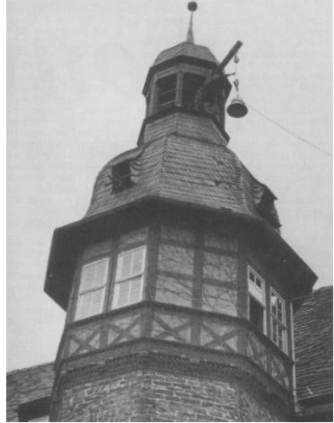
Die Glocken werden auf den Turm gezogen!
