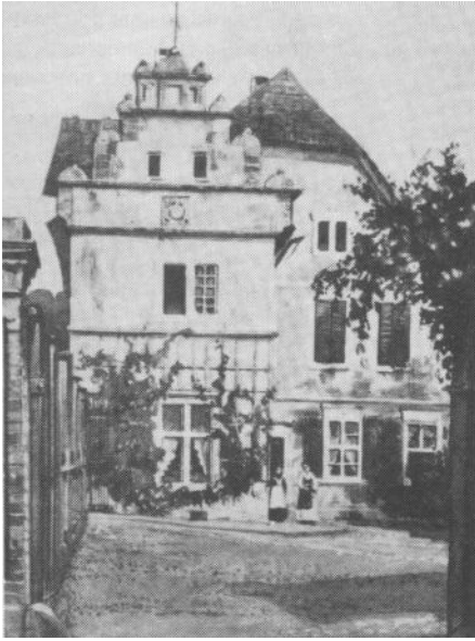
Rodewiekstraße 26 in Höxter Renaissance-Giebel von 1593 Rückwärtiger Fachwerkbauteil vor 1891
