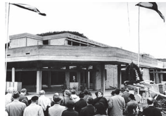
Richtfest Schulgebäude Schulzentrum 1973
