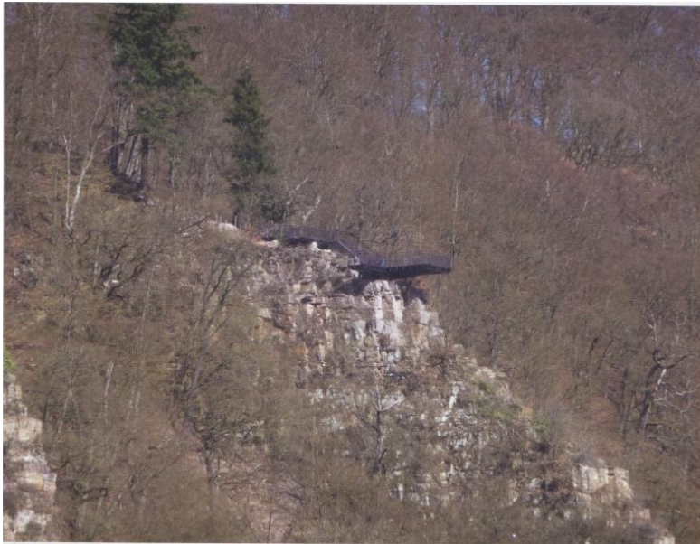
Blick auf den Weser-Skywalk von der Bundesstraße Herstelle/Bad Karlshafen
