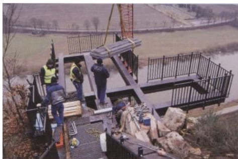
Montagearbeiten an der Plattform
