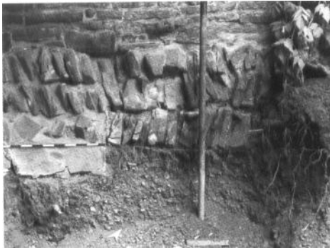
ABB.1 Obere Mauerstraße 28: Packlagenfundament der Stadtmauer
