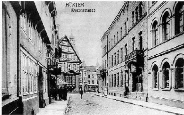
ehemaliger „Berliner Hof“, Weserstrasse 6
