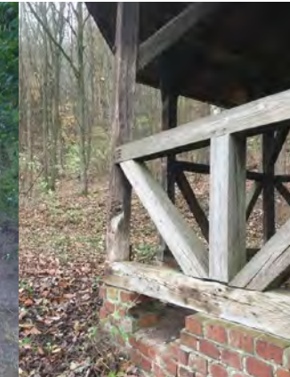
Zustand des alten Fundaments vor der Erneuerung
