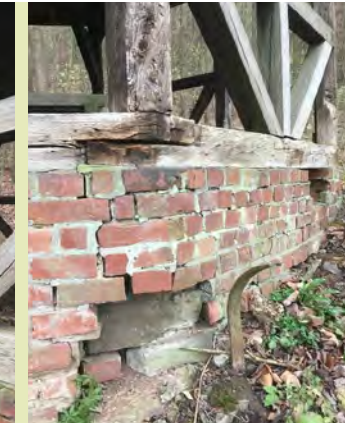
Zustand des alten Fundaments vor der Erneuerung
