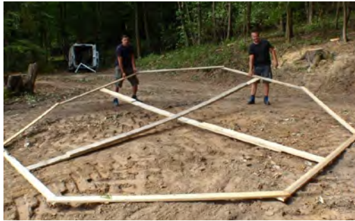
Erstellung des Fundaments
